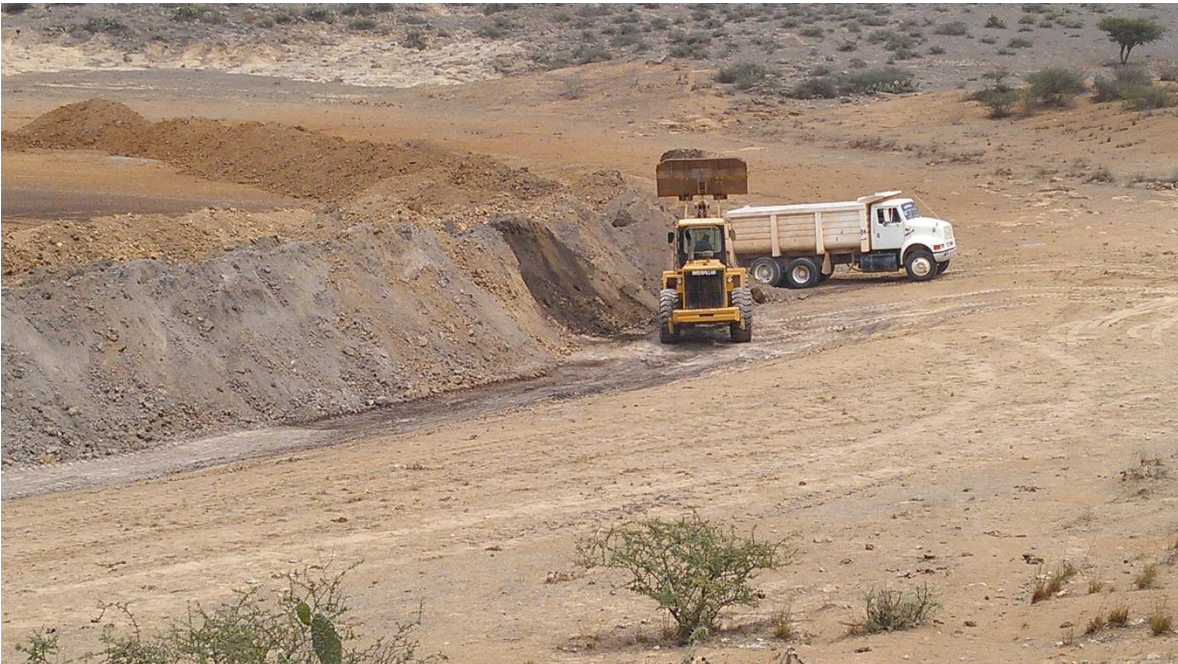
DESAZOLVE DE ESTANQUES, PRESAS Y CONSTRUCCIÓN DE BORDOS. VARIAS COMUNIDADES.
