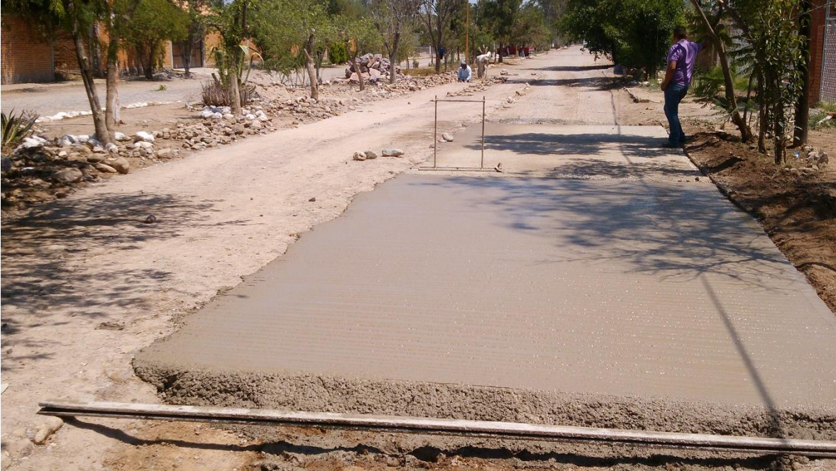
REHABILITACIÓN Y PAVIMENTACIÓN DE CALLES. COMUNIDAD REAL DEL POTOSÍ.
