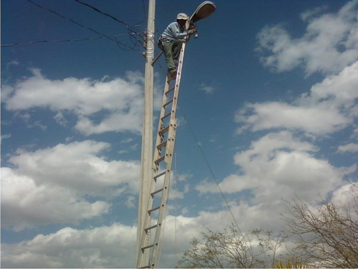
CAMBIO DE LÁMPARAS, COLOCACIÓN DE BALASTRAS Y FOCOS. VARIAS COMUNIDADES.
