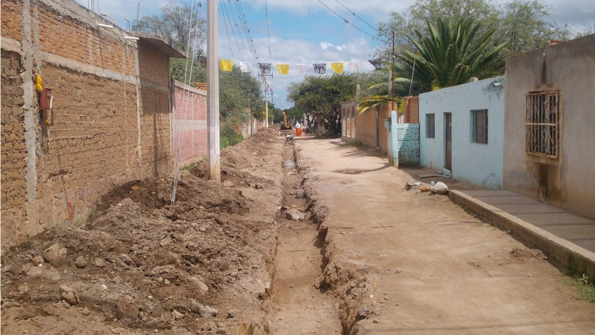
CONSTRUCCIÓN DE LA OBRA DE DRENAJE EN LA COMUNIDAD DE PLANTA DEL CARMEN.
