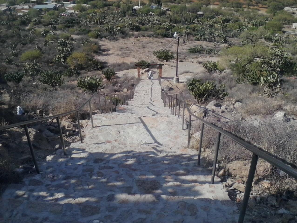
REHABILITACIÓN Y CONSTRUCCIÓN DE ESCALINATAS IGLESIA DE LAS PEÑITAS. COMUNIDAD PORTEZUELO.
