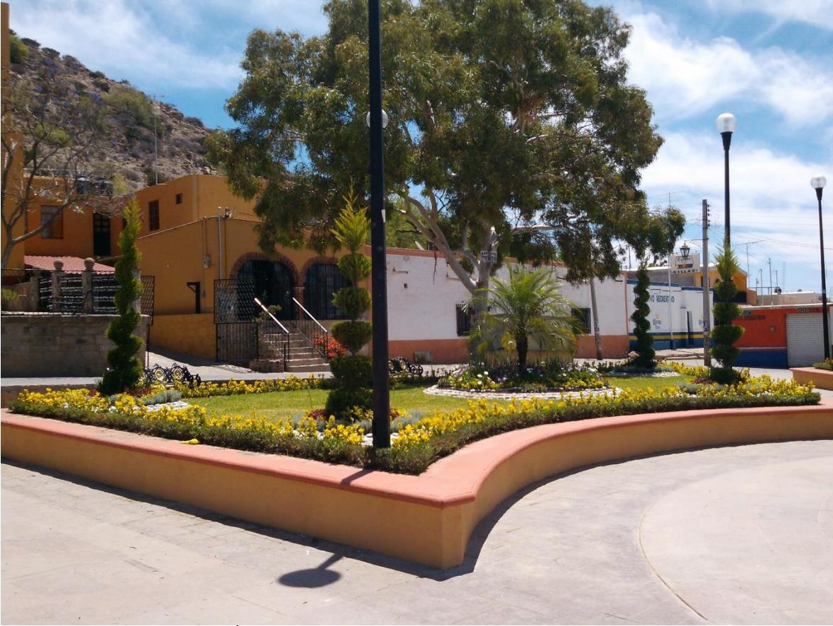
REHABILITACIÓN Y EMBELLECIMIENTO DE PLAZA PRINCIPAL DE PORTEZUELO.
