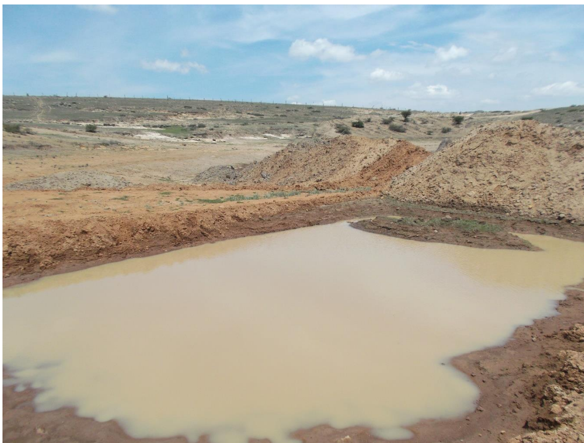
DESAZOLVE DE ESTANQUES, PRESAS Y CONSTRUCCIÓN DE BORDOS. VARIAS COMUNIDADES.
