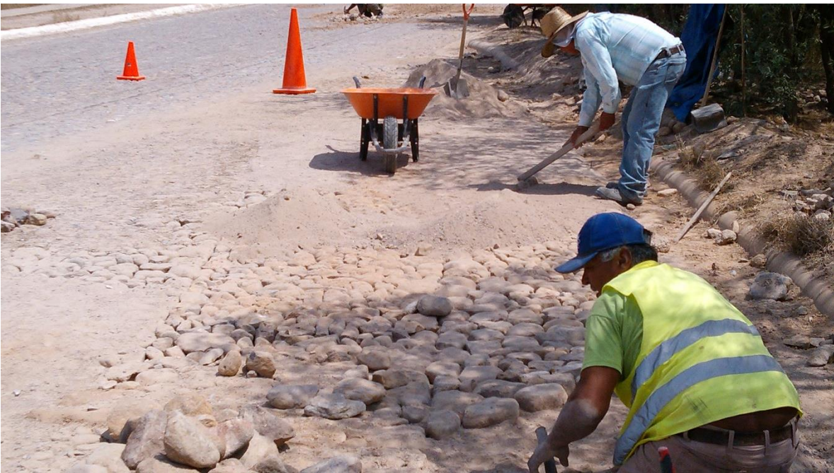
REHABILITACIÓN DE CALLES. COMUNIDAD REAL DEL POTOSÍ.
