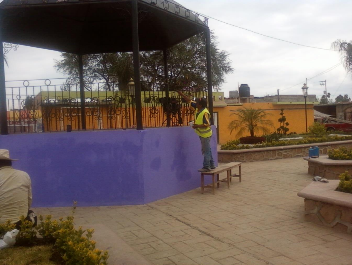
REHABILITACIÓN Y EMBELLECIMIENTO DE PLAZAS PÚBLICAS. COMUNIDAD PLANTA DEL CARMEN.
