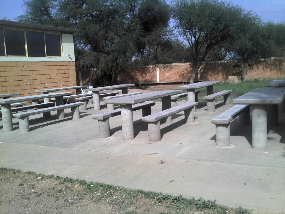
CONSTRUCCIÓN DE BAÑOS Y DESAYUNADORES. COMUNIDAD PLANTA DEL CARMEN.
