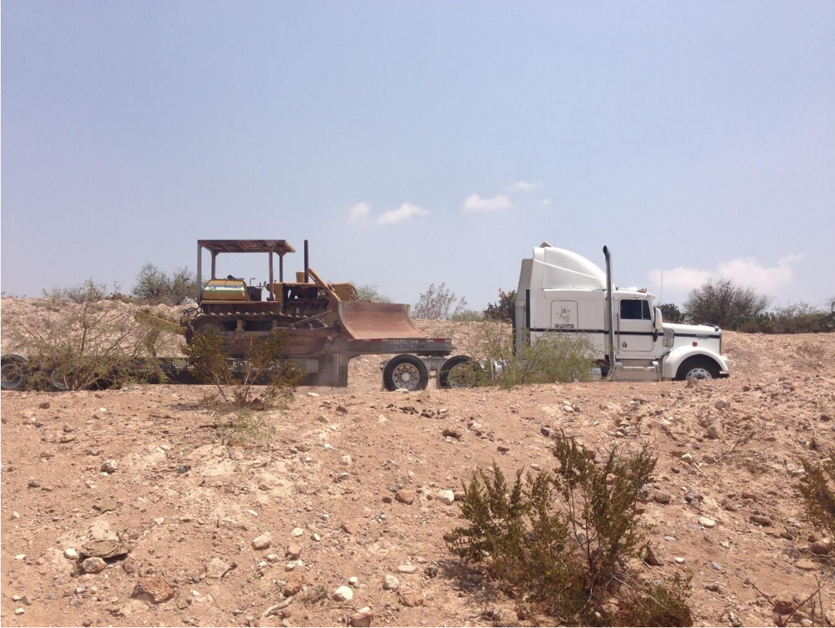
INICIO DE LOS TRABAJOS DENTRO DEL PROGRAMA COSECHA DE AGUA.
