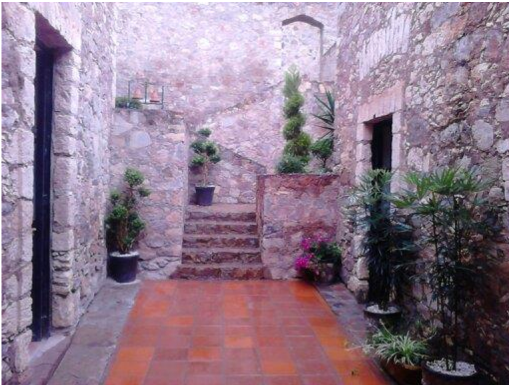
REHABILITACIÓN DE OFICINAS ADMINISTRATIVAS ALTERNAS A LA PRESIDENCIA MUNICIPAL.
